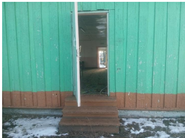
Фото 32. Корпус №5 пожарный выход
